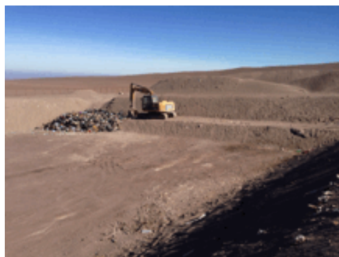
Inspección relleno sanitario
