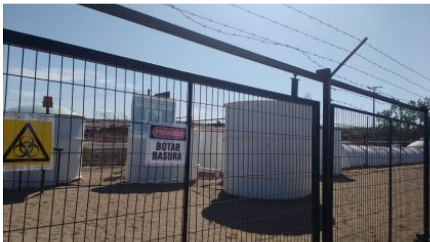
Planta de Tratamiento de aguas servidas, en Matilla.
